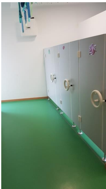
Sanitärbereich mit Dusche
